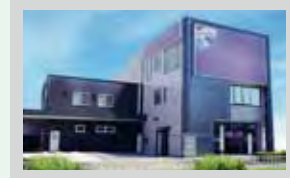
小田井ホール 名古屋市長久手区小田井5-148 平面駐車場 100台
